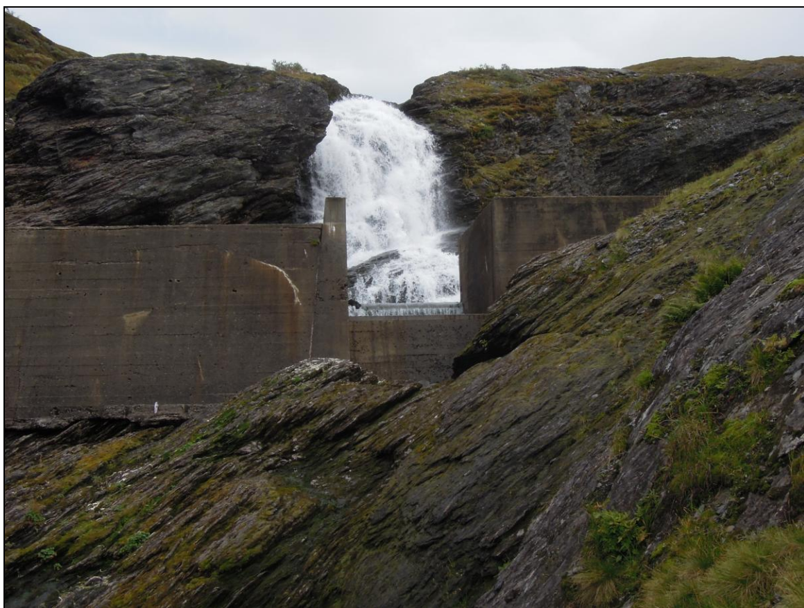
Figur 6.4. Fossefall ved eksisterende dam med inntak til tunneloverføring. Kraftstasjon er planlagt å bygges ved denne dammen. Foto: Leif Appelgren
